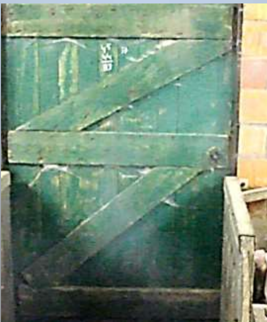
Figuur 11 Kieren kunnen zichtbaar worden gemaakt met rook
