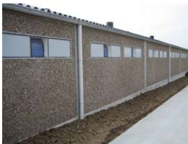
Figuur 3 Inlaatventiel (buitenkant)
