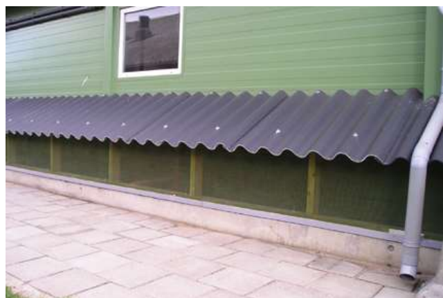
Figuur 3 Luchtinlaat bij kanaalventilatie (bovengronds)
