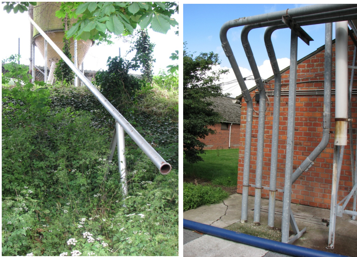
Foto 12. Plaatsing van silo's voor levering mengvoeders zonder betreden van de propere weg
