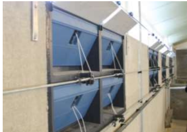
Figuur 2 Inlaatventiel (binnenkant)
