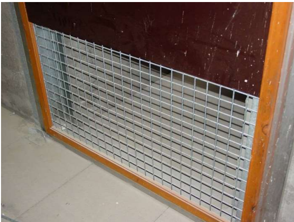
Figuur 4 Deurventilatie met variabele opening
