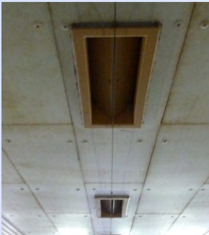
Detail van het waspakket van de luchtwasser (boven) en de ventielopeningen van de plafondventilatie (onder).
